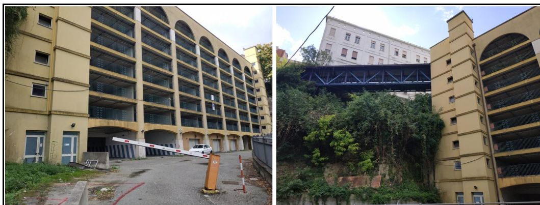
Figura 26 - L'ascensore e la passerella al parcheggio Politeama – non operativo
